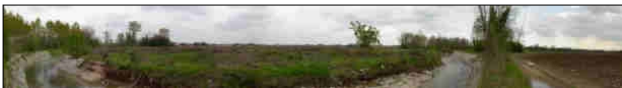
Foto 28: Il Cormor si presenta lungamente canalizzato con le sponde rivestite da una scogliera.
