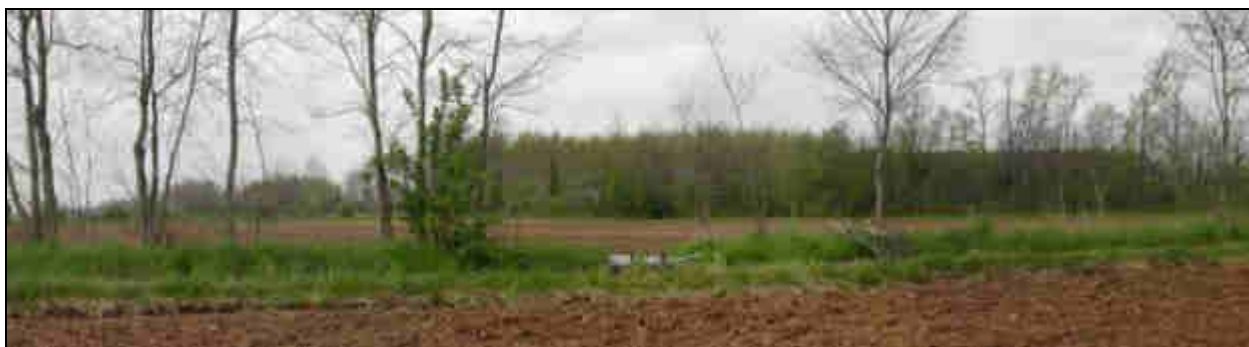
Foto 2: La presenza del viadotto presso Basagliapenta si confronta con un'area circostante caratterizzata da un paesaggio a visuale parzialmente aperta, generato dalle quinte arboree residue dei campi chiusi originari.
